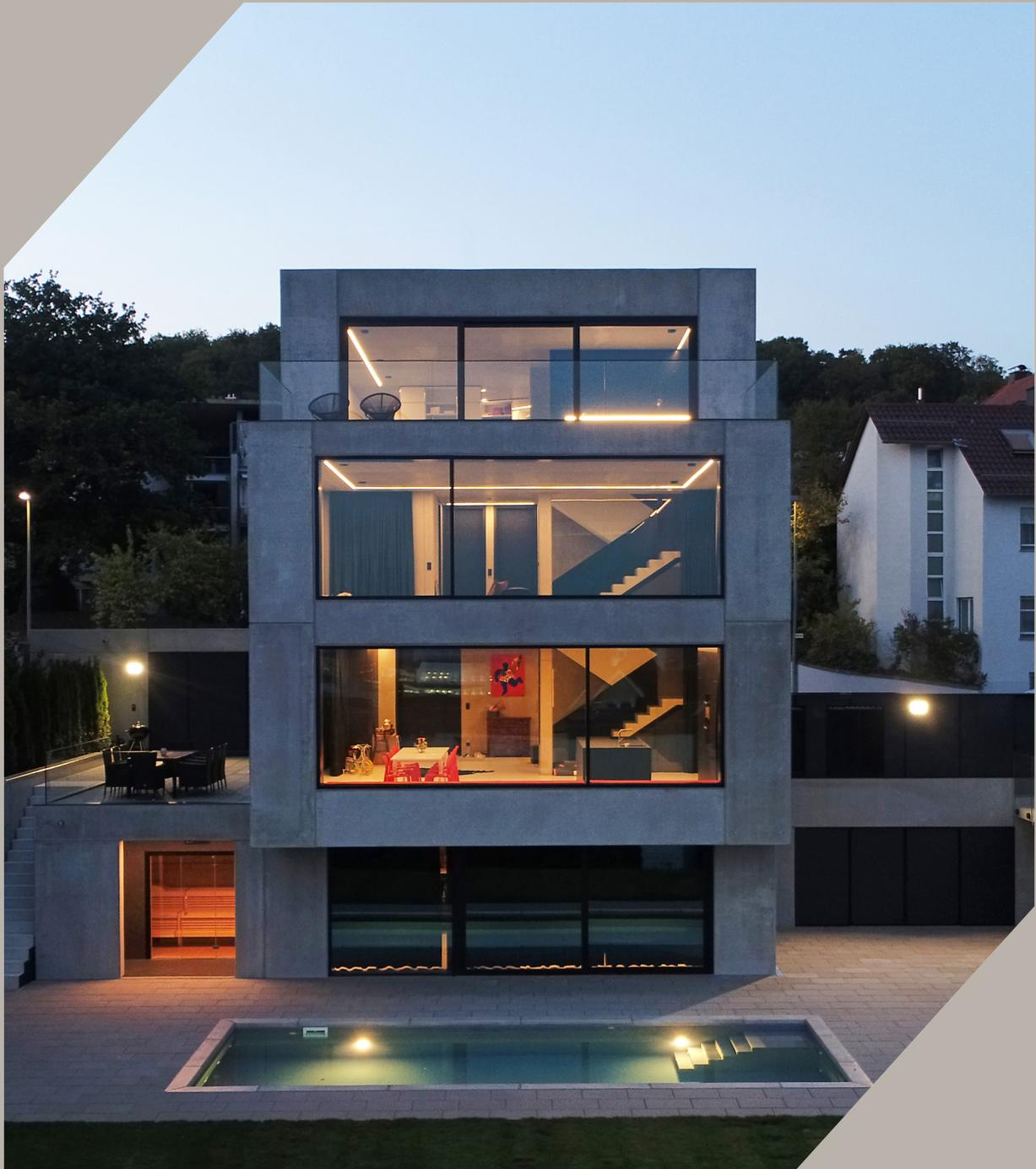
die präzise und homogene betonoptik des 4-geschossigen baukörpers ist nicht zuletzt durch eine konsequente detailausbildung entstanden. der zweiseitige aufbau mit kerndämmung und die konstruktiv erforderlichen fugen wurden fassadenübergreifend angeordnet und erzeugen sowohl im fassadenbereich als auch im innenraum eine durchgehende linienführung.
